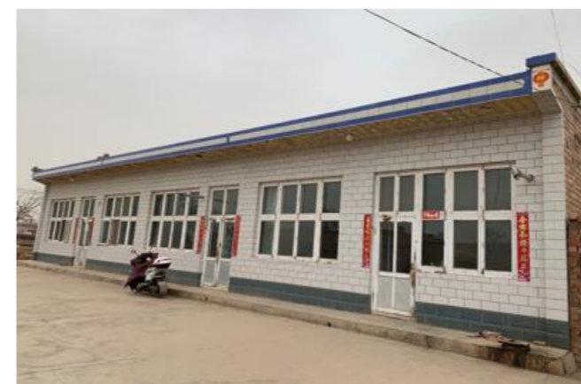
图 2-7-1 砖混结构房屋
