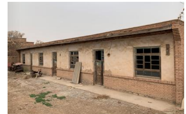
图 2-7-2 土木结构房屋（闲置）
