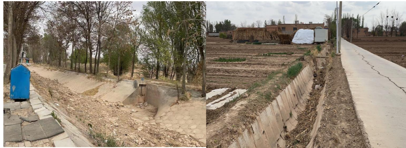
图 2-19 中渠村水利设施图
